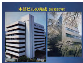
毛呂病院本部ビル 完成
